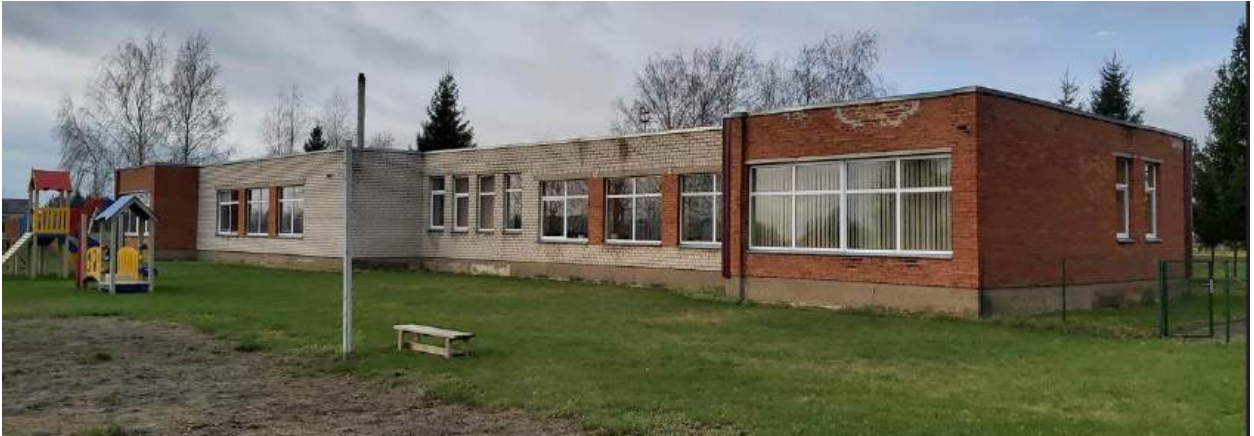
2 pav. Remontuojamo pastato fotografacija (2020-11 mėn.).
