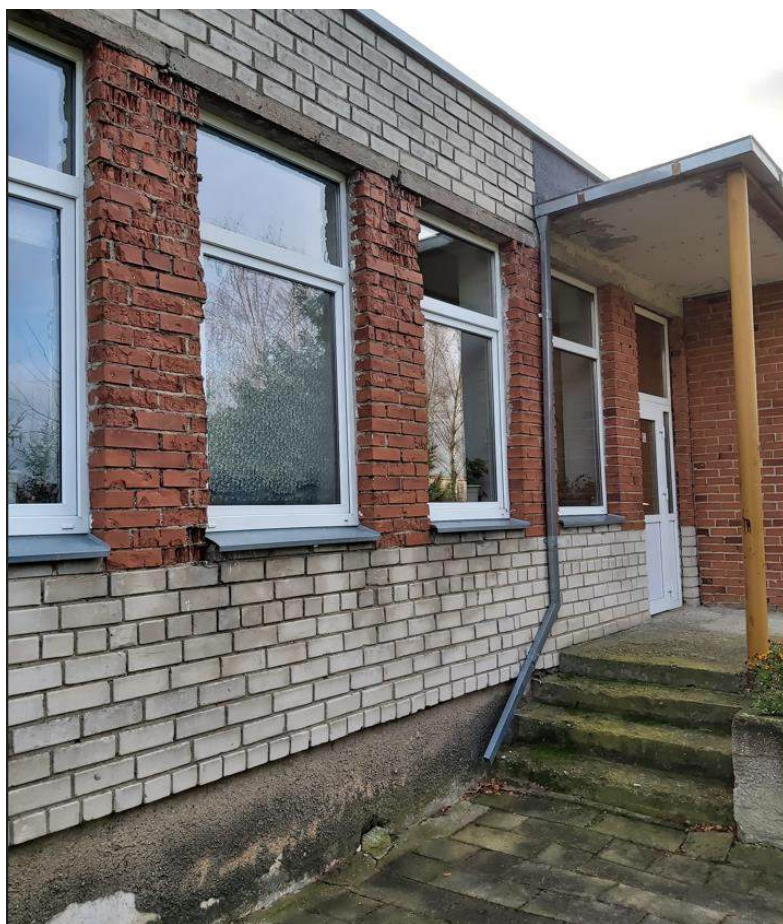
5 pav. Remontuojamo pastato fotofiksacija (2020-11 mėn.).
