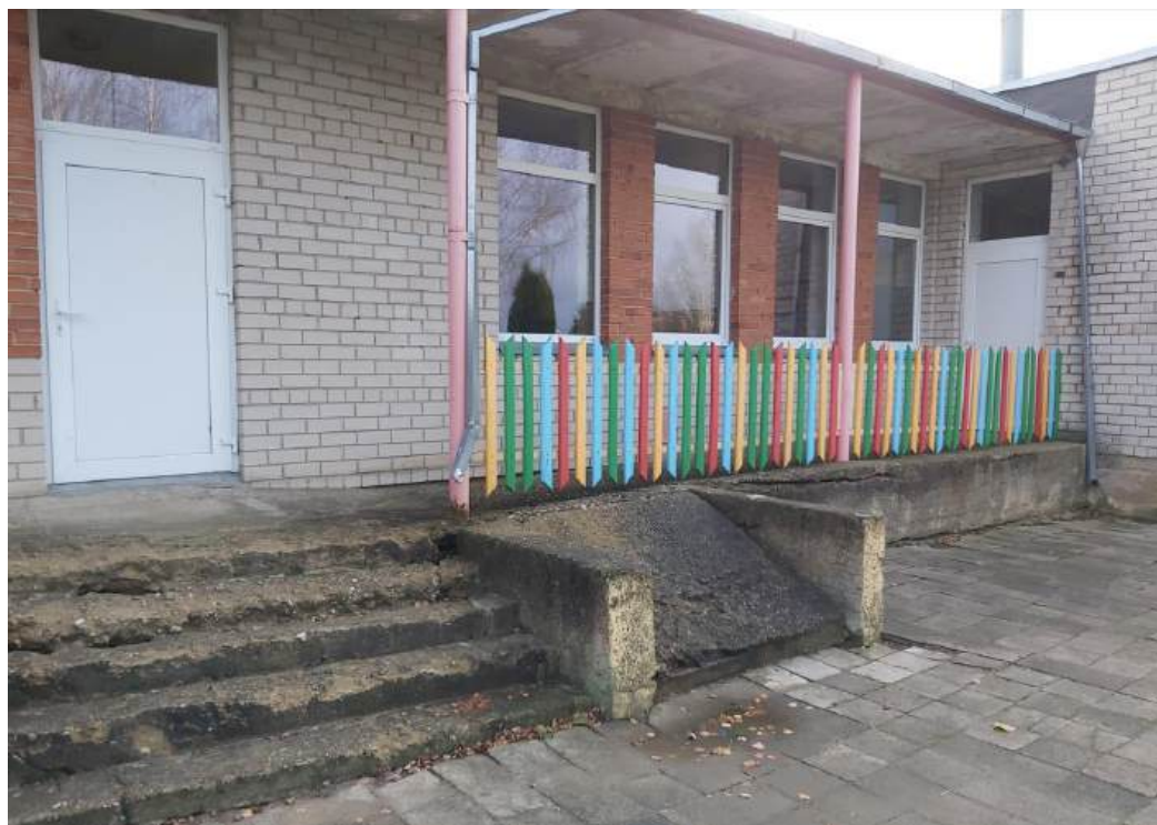
4 pav. Remontuojamo pastato fotofiksacija (2020-11 mėn.).
