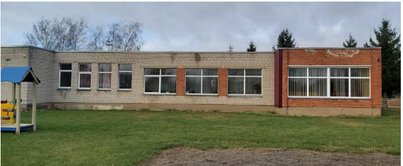
1 pav. Remontuojamo pastato fotofiksacija (2020-11 mėn.).
