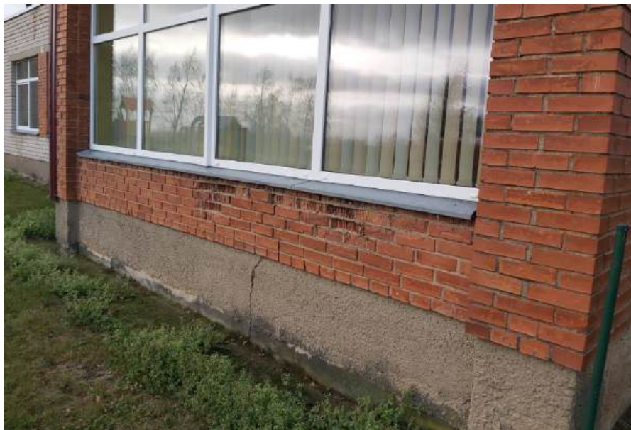
6 pav. Remontuojamo pastato fotofiksacija (2020-11 mėn.).
