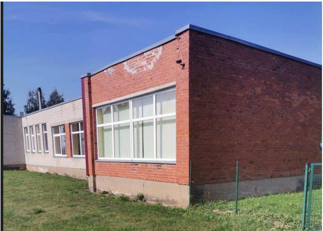
3 pav. Remontuojamo pastato fotografacija (2023-08 mėn.).
